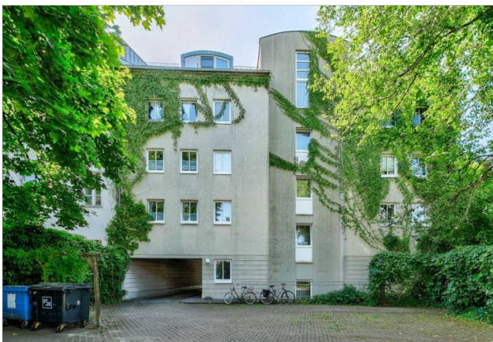
Rückansicht der Fassade
