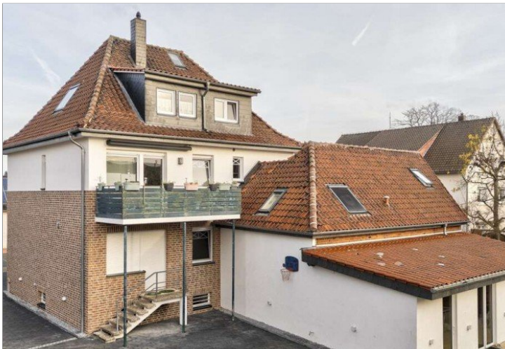
Hofansicht mit Anbau und Stellfla
