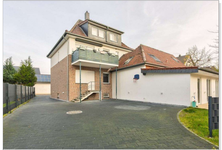
Hofbereich mit Anbau und Stellfla
