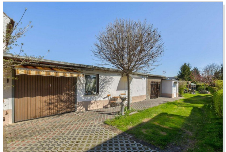
Nebengebäude mit Garagen und Hofbereich
