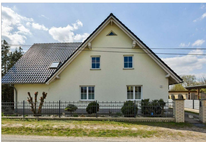
Straßenansicht des Hauses
