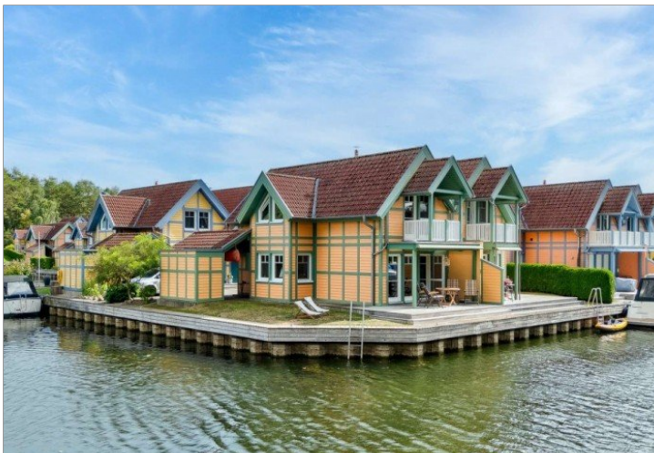
Reiheneckhaus direkt am Wasser
