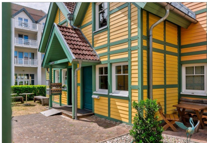
Hauseingang mit überdachtem Eingangsbereich
