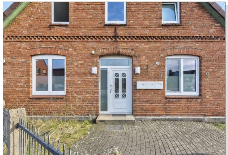
Straßenansicht - Wohn- und Geschäftshaus (Eingangsbereich)
