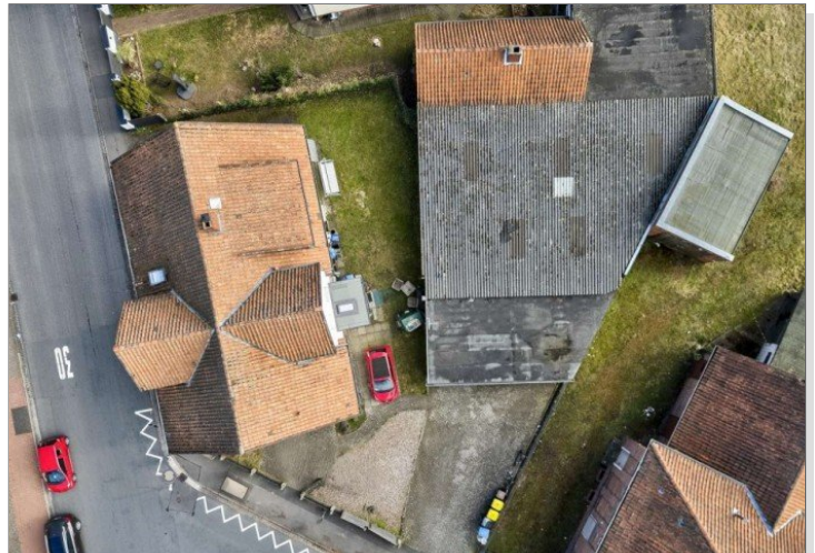
Luftaufnahme - Gebäude und Garagenanlage
