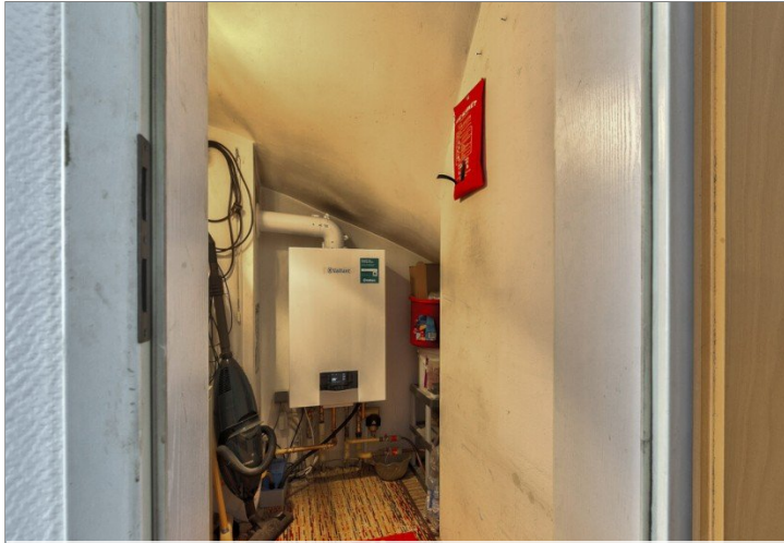
Heizungsraum & praktischer Abstellraum
