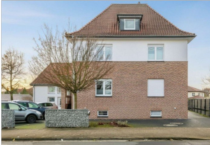
MFH - Straßenansicht des Mehrfamilienhauses
