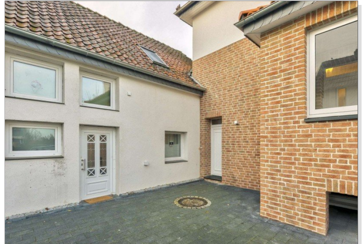
MFH - Ansicht mit Hof- und Zugangsbereich
