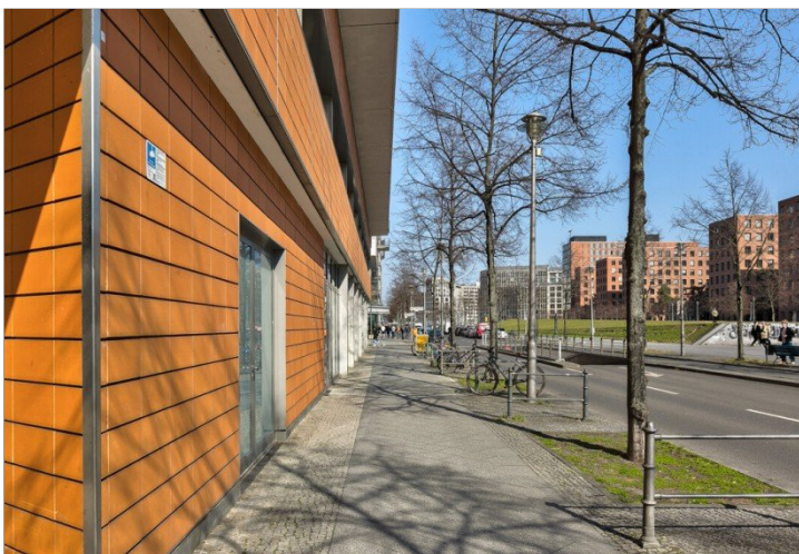
Fahrradraum mit Zugang von der Straße
